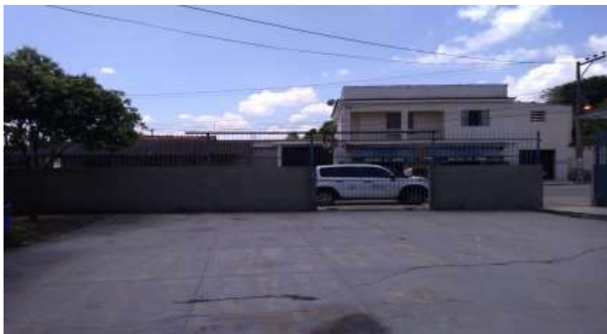
Figura 3: Piso do pátio
